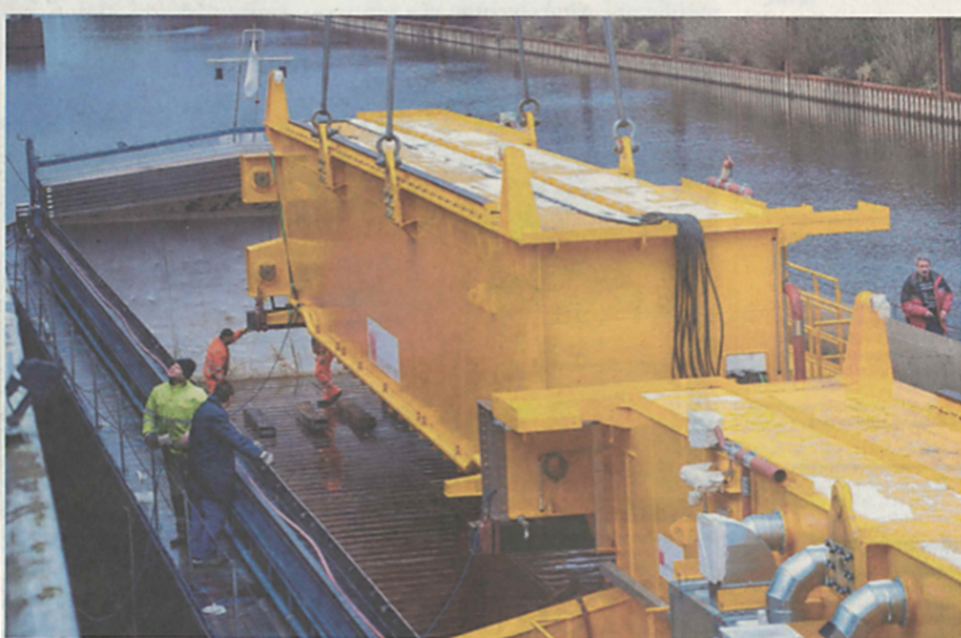
Im Akener Hafen wurden gestern die ersten Teile des Krans auf ein Schiff verladen.
